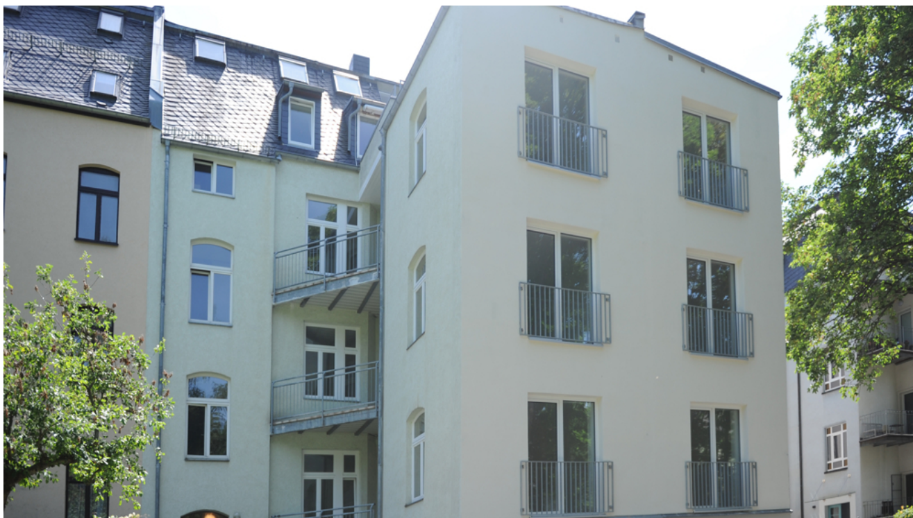
Friedrich-Engels 17 und 19, Rückfassade
