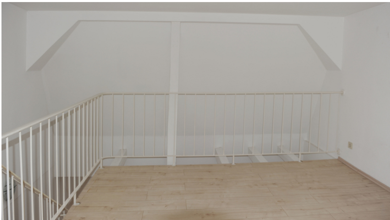
Friedrich-Engels 47, WE 5, Arbeiten
